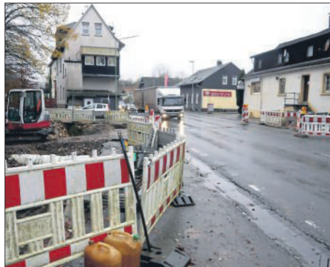
An der Bergstraße werden Arbeiten an Versorgungsleitungen vorgenommen. Außerdem wird eine Brücke erneuert. ▪ Foto: Spies
